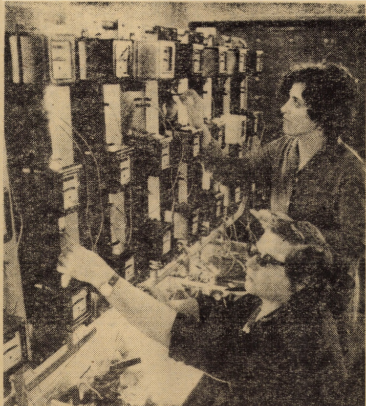
Masa de verificări a contoarelor monofazice de la I.R.E. Sibiu, realizată prin autoutilare, aduce importante economii valutare
