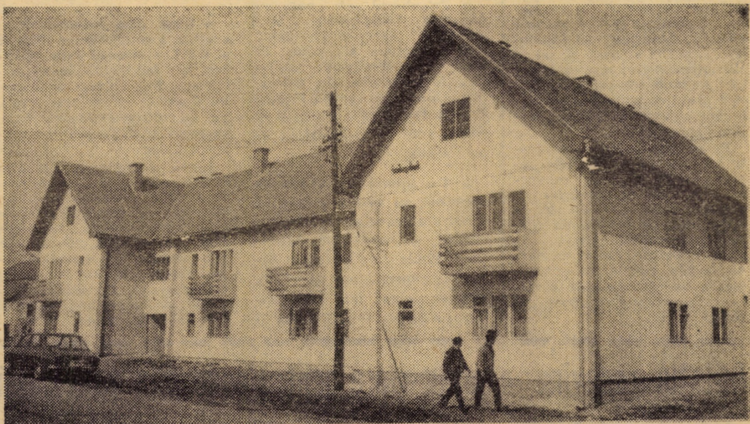
Noi construcții de locuințe în comuna Șura Mică
