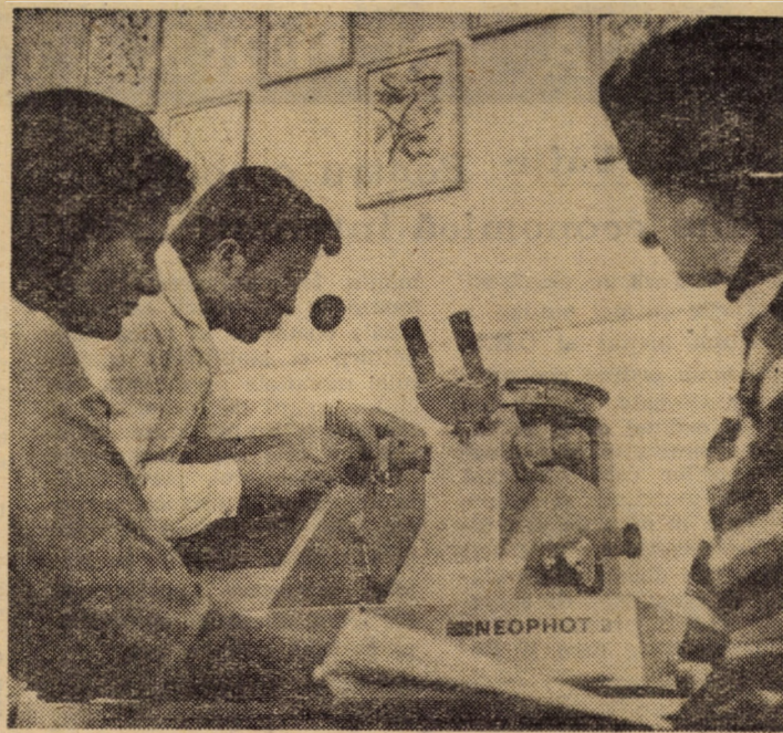
Facultatea de mecanică Sibiu. Lucrări de cercetare științifică efectuate de studenți la microscopul metalografic „NEOPHOT-210” — o nouă dotare a laboratorului
