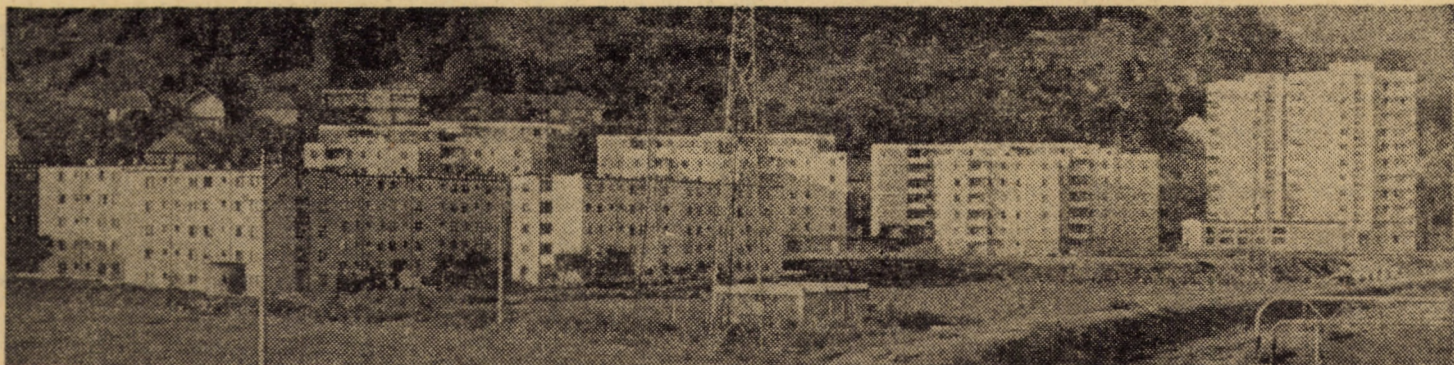
Din peisajul noilor construcții de locuințe ale cartierului Gh. Gh. Dej, din municipiul Mediaș
