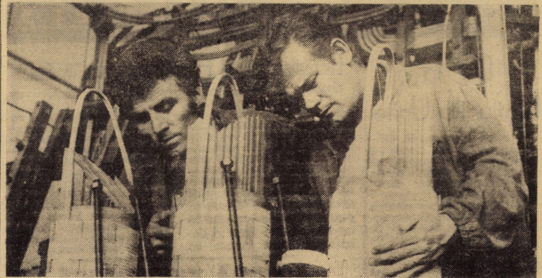
Montarea bobinelor la un transformator de n. ul executată de electricienii Iosif Szabo și Liviu Agîrbiceanu din secția reparat aparate electrice de la I.R.E. Sibiu Foto: FRED NUSS
