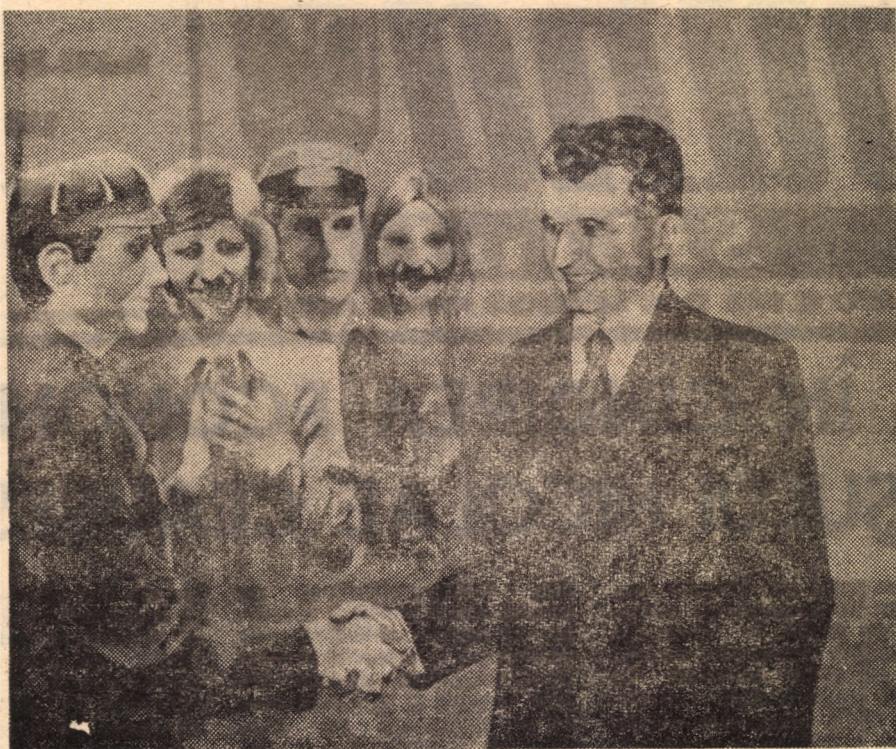
„Vizită pe șantierul tineretului”
