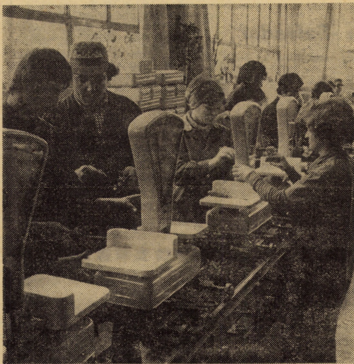
Întreprinderea „Balanța” Sibiu. Prin perfecționarea și mecanizarea diferitelor operații la banda de montaj a balanțelor semiautomate de 10 kg, cum sînt acționarea pneumatică a sculelor, ambalarea produselor la capătul benzii, etc., productivitatea va crește simțitor
