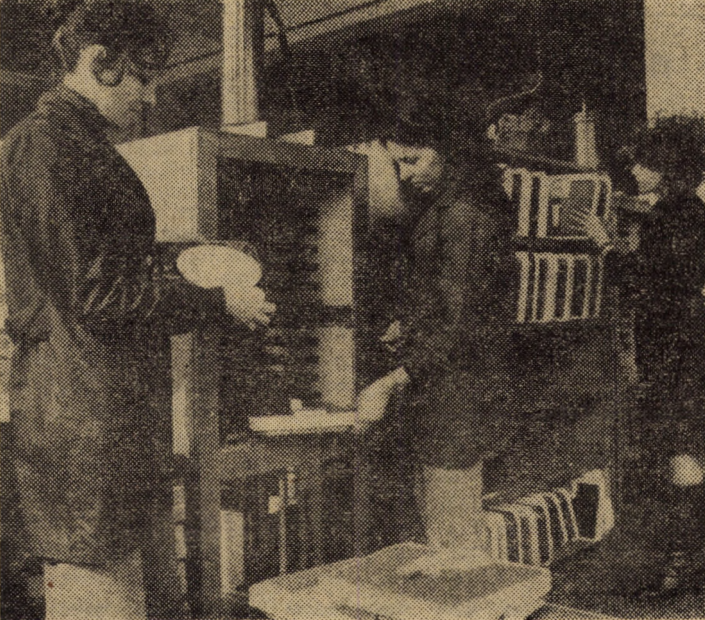
Standul de justare și verificare a cîntarelor dinamometrice pentru persoane - o realizare prin autoutilare în atelierul balanțe uz casnic al întreprinderii „Balanța” Sibiu Foto: FRED NUSS
