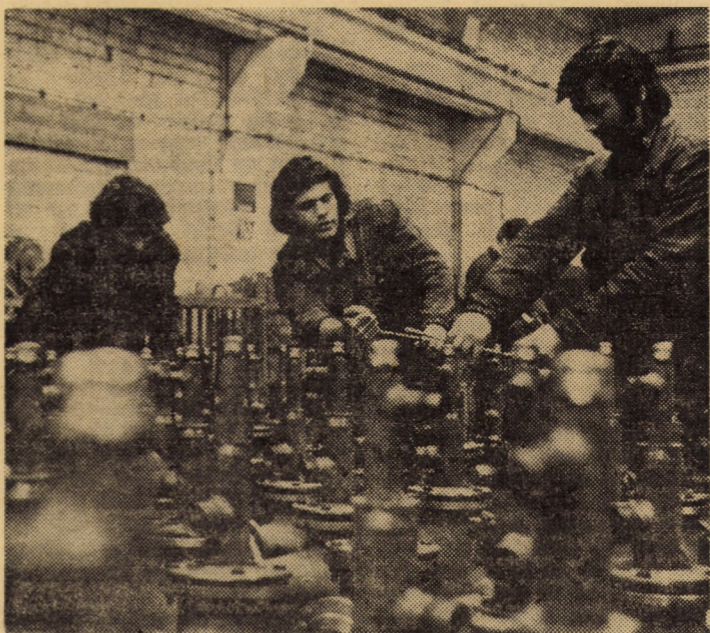
Uzina mecanică gaz metan Mediaș. Linia de montaj a arzătoarelor industriale pentru cuptoare de tratament, folosite în marile combine
