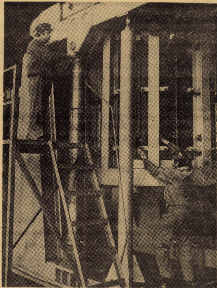
Secvență de muncă din secția utilaj metalurgic a întreprinderii „Independența” Sibiu: muncitorii Goia Roman și Andrei Lăpăduș efectuând ultimele verificări la modelul pentru granulatorul concasor de Ø 1 250 mm, destinat exportului
