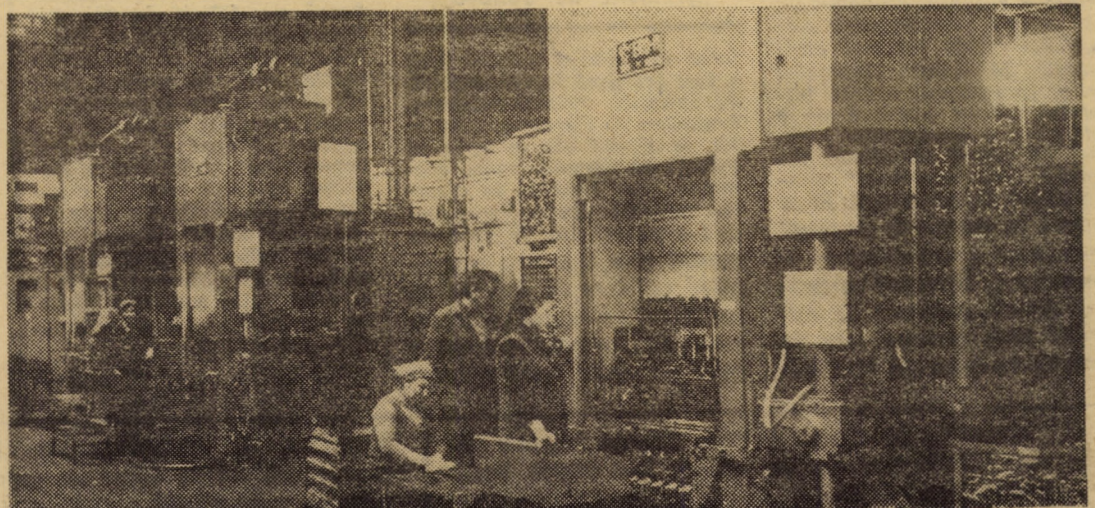
Aspect din compartimentul mecano-energetic, atelierul autoutilării, al întrepr. „Emailul roșu“ Medias
