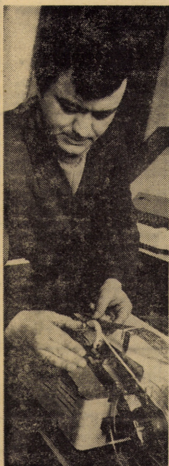
Întocmirea benzilor perforate necesare mașinilor unelte cu comandă program la întreprinderea „Mecanica” Sibiu
