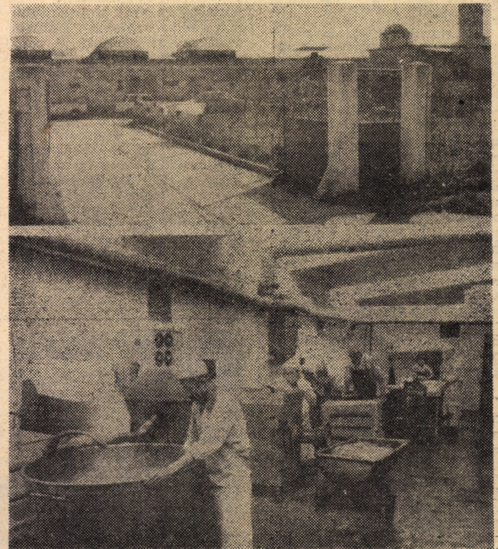
La Stația preparate din carne a I.A.S. Șura Mică condițiile de muncă s-au îmbunătățit substanțial în urma lucrărilor de modernizare efectuate recent. Printre altele aici au fost montate lumina-toare din fibră de sticlă care au exclus în totalitate folosirea iluminatului electric. De asemenea, în atelierele de fabricație au fost introduse o serie de utilaje realizate prin autototare în valoare de cca. 70 000 lei Foto: FRED NUSS
