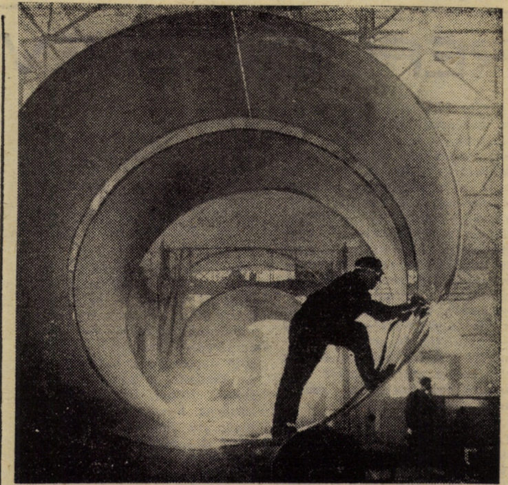
Finisarea viroelor pentru conductele forțate destinate hidrocentralelor la cazangeria întreprinderii „Independența” din Sibiu Foto: FRED NUSS
