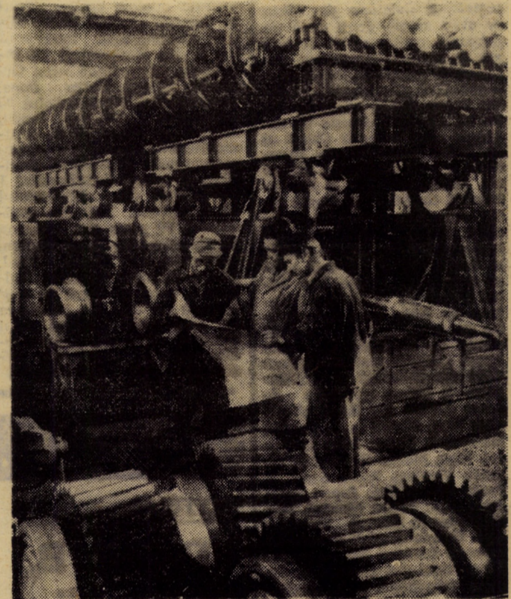
Hamicii constructori de mașini grele de la întreprinderea „Independența II” Sibiu vor preda peste puțin beneficiarilor externi un nou utilaj gigant, cîntărind peste 1 000 tone (!) Este vorba de patul de răcire al unei complexe instalații, de mare capacitate, pentru laminarea tablei. Lucrările de montaj sînt executate de o echipă condusă de maistrul Ioan Nan și șeful de echipă, Mihai Zolozzech. Foto: FRED NUSS
