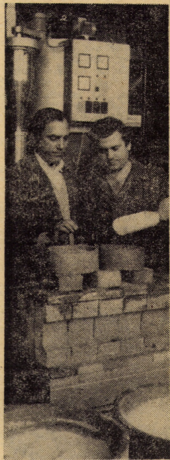
Întreprinderea „Emailul roșu” Mediaș. Verificarea pigmentilor rezultați de la instalația de calcinare, efectuată de sing. Inache Ioan și preparatorul Ovidiu Moldovan Foto: FRED NUSS
