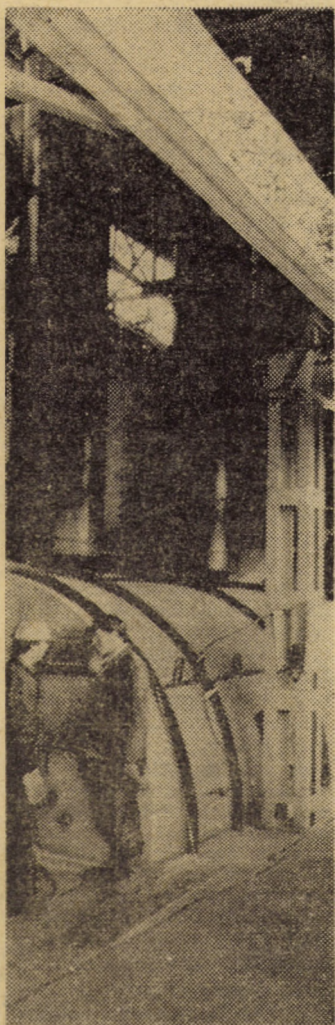
Instalația pentru fabricarea pulberilor de zinc, recent dată în funcțiune la I.M.M.N. Copșa Mică Foto: Fred NUSS
