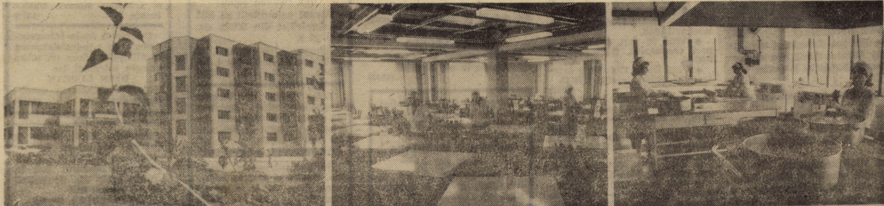
Ansamblul arhitectonic al orașului Cisnădie a fost întregit cu această modernă construcție. La parter a fost dată în folosință cantina-restaurant a întreprinderii
