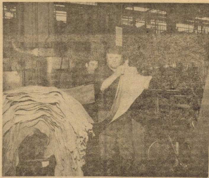
Atelierul cenușar-tăbăcit al secției tăbăcării de la întreprinderea „13 Decembrie”, Sibiu: Nicolae Jorja și Marcu Marcu, tăbăcari cu o vastă experiență profesională, deservind o mașină de despicat piei
