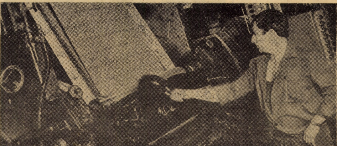
Întreprinderea „Tirnavă” Medias. Cu ajutorul valțurilor realizate prin procedeul fotografurii, montate apoi pe mașini de imprimat în 6 culori, utilaje de înaltă tehnicitate din secția finisaj, se obțin țesături într-o mare varietate de modele Foto: Fred NUSS
