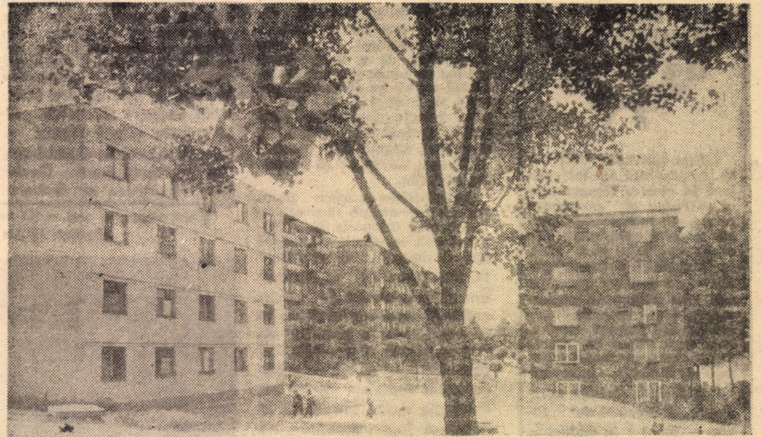
În ultimii ani și în orașul Copșa Mică, o bună parte din muncitorii celor două mari întreprinderi — I.M.M.N. și „Carbosin” — s-au mutat în locuințe noi. În fotografie: vedere parțială a cartierului de locuințe. Foto: Fred NUSS
