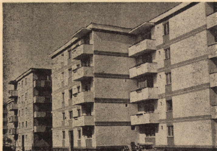
Noi construcții de locuințe în cel mai tânăr cartier sibian „Valea Aurie” Foto: Fred NUSS
