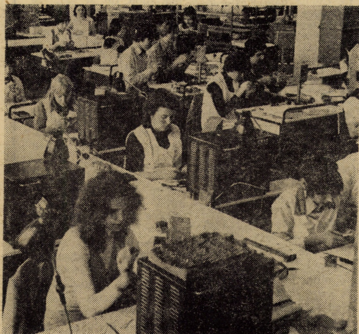
Printre obiectivele industriale moderne construite pe meleaguri si-biene în „Epoca Ceaușescu” se numără și întreprinderea de relec-Medias, de unde vă înfățișăm o linie de montaj Foto: Fr. NUSS
