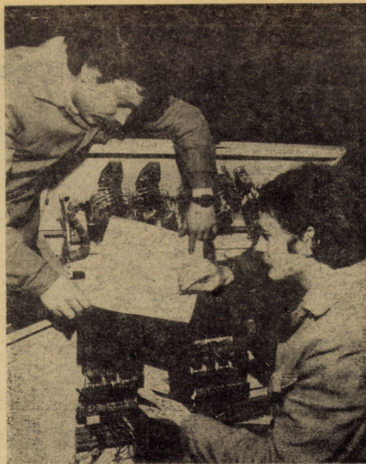
Buna funcționare a utilajelor e strîns legată de modul corect în care au fost executate lucrările la panourile electrice de comandă. Iată-i, în fotografie, pe doi dintre electricienii secției montaj I a întreprinderii „Mecanica” Sibiu, Octavian Popa și Aurel Isailă, efectuînd un ultim control al circuitelor înainte de-a pune în funcțiune o presă mecanică Foto: Fred NUSS
