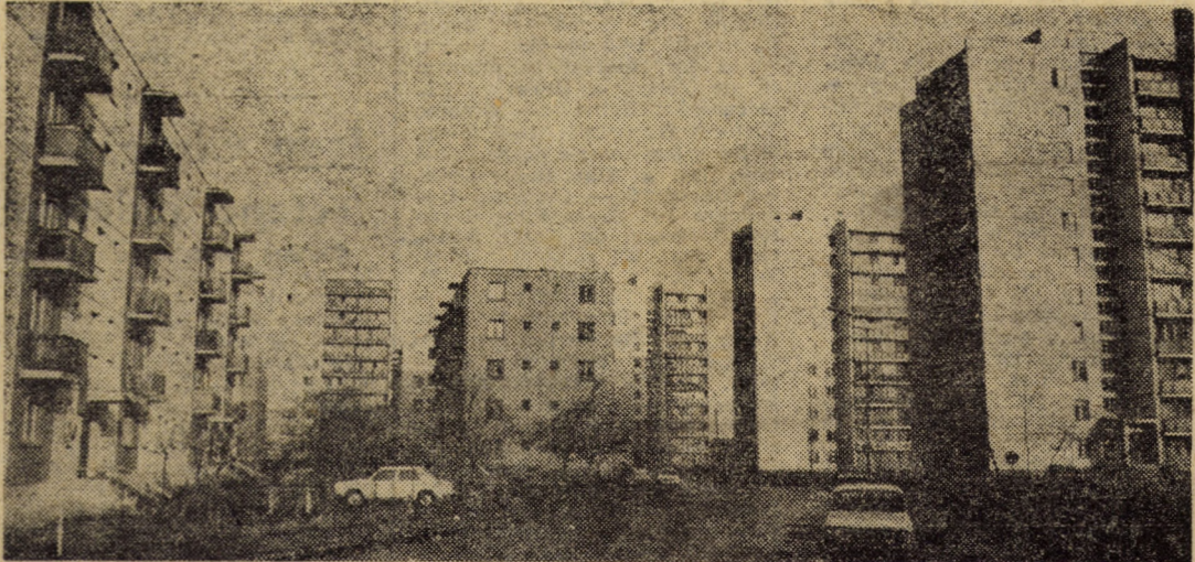
Asemenea tuturor orașelor țării, și municipiul Sibiu a cunoscut în ultima perioadă o dezvoltare și înflorire fără precedent. Geometria pe verticală a blocurilor de locuințe din cartierul Hipodrom constituie o dovadă elocventă în acest sens
