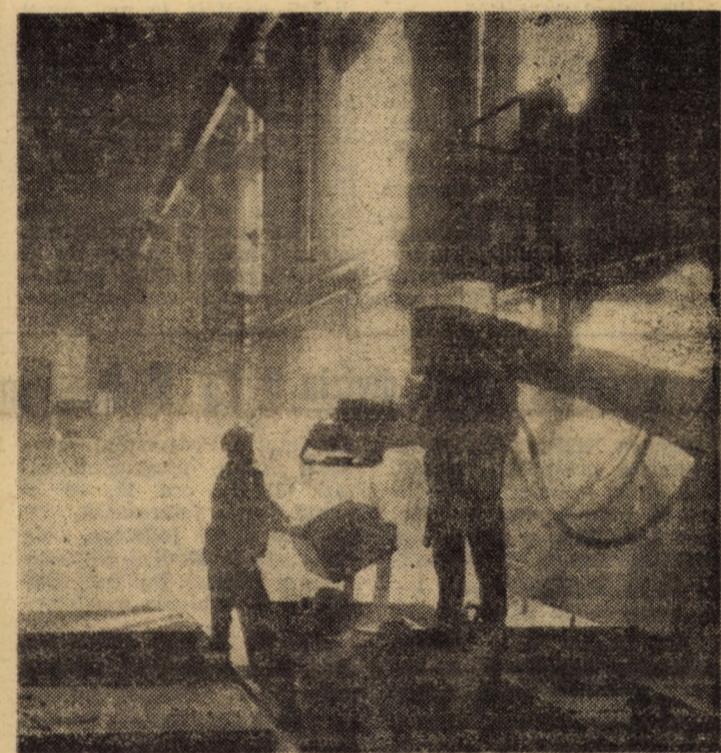
Fabrica de utilaj metalurgic și turnătorii „Independența” II — aspect din hala turnătoriei
