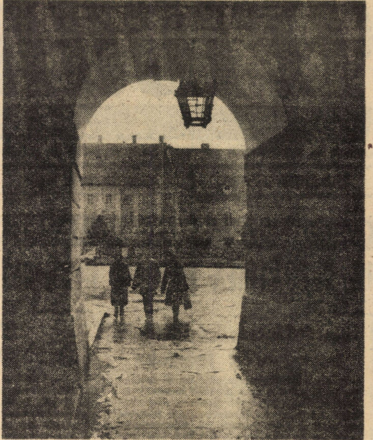
Prefinșă peste vechi arcade, o nouă primăvară se instalează în cetate Foto: Fred NUSS
