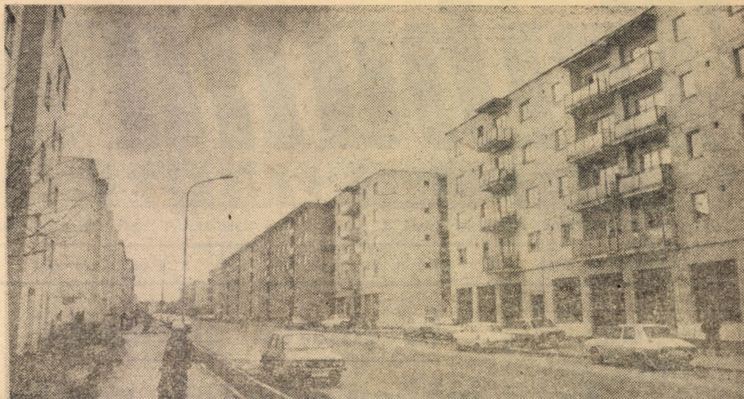
Str. Semaforului din cartierul Vasile Aaron, una dintre principalele artere de intensă circulație din zonele nou construite, se prezintă azi sub aspectul civilizat al majorității străzilor municipiului Sibiu Foto: Fred NUSS
