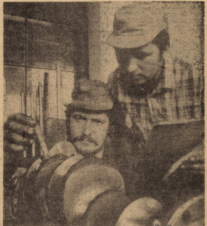
Doi dintre mecanicii cu o bună pregătire profesională, Helmuth Kessner și Martin Kepp din atelierul montaj general al Centrului de reparații capitale Tîrnava, controlînd cotele la un arbore cotit pentru motoarele D 110 Foto: Fred NUSS
