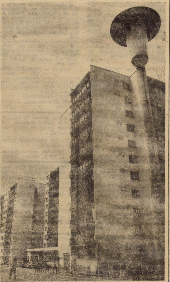
Geometria pe verticală a blocurilor de locuințe din cartierul „Gura Cimpului” constituie o dovadă elocventă pentru perioada de dezvoltare fără precedent prin care a trecut municipiul Medias, asemenea tuturor orașelor țării, în anii care au trecut de la Congresul al IX-lea al partidului. Foto: Fred NUSS
