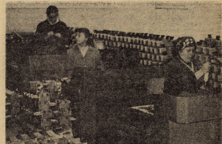
Fază de montaj a elementelor cu acționare hidropneumatică la „Balanța“ Sibiu. Foto: Fred NUSS
