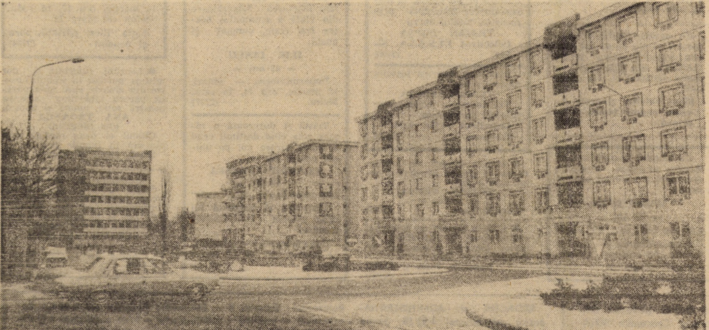
Noi construcții de locuințe, ridicate cu puțin timp în urmă pe str. Școala de inot din Sibiu
