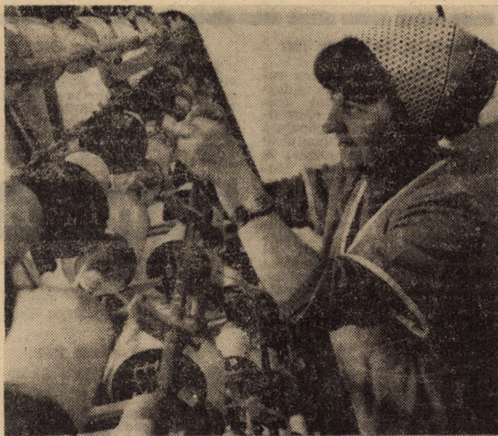
Întreprinderea „7 Noiembrie” Sibiu. La un urzitor cu 40 fuse, Maria Ersei, muncitoare frunțasă în secția bobinat, realizează urzeli de calitate pentru faza înfășurat elastic
