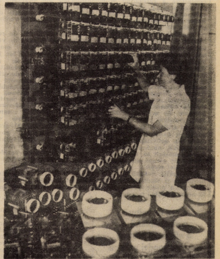
Întreprinderea de relee Mediaș. În imagine standul de probă și rodaj pentru releele de timp, operațiune necesară în asigurarea parametrilor tehnico-funcționali și calitativi ai acestor produse din domeniul electrotehnicii.
