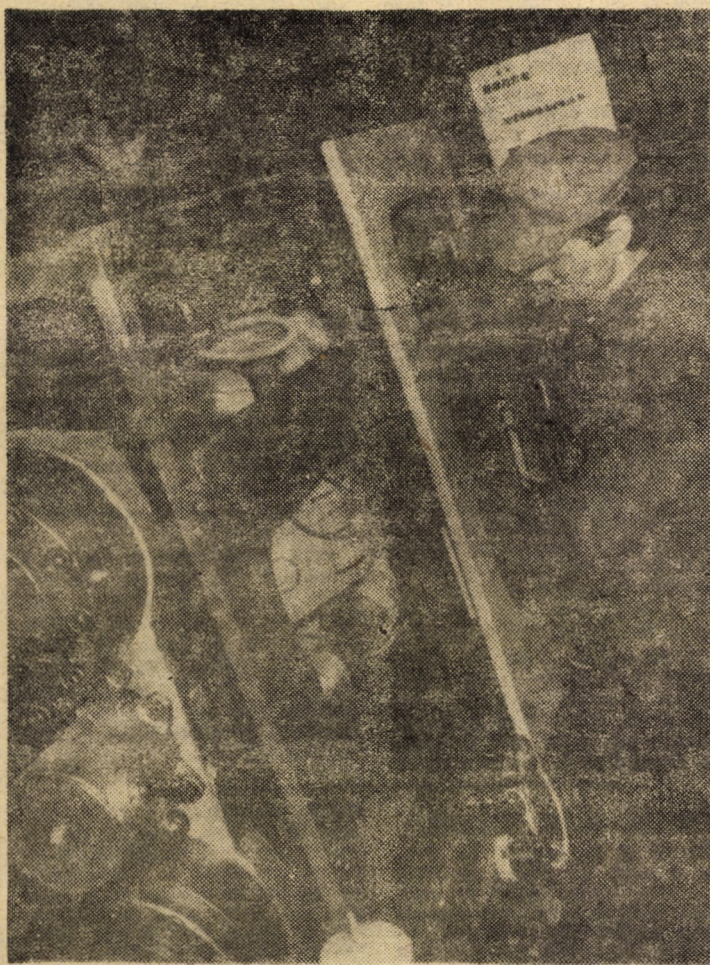
Întreprinderea Mecanică Sibiu. Mașini de injectat mase plastice în fază de montaj general Foto: Fred NUSS
