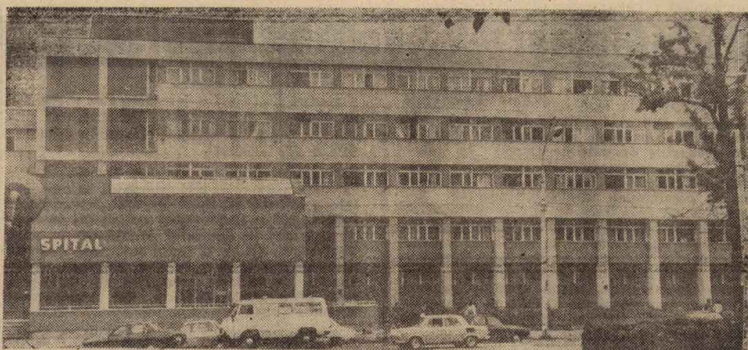
Una din construcțiile de mare interes social, ridicată în anii din urmă în municipiul nostru — Spitalul Județean Sibiu
