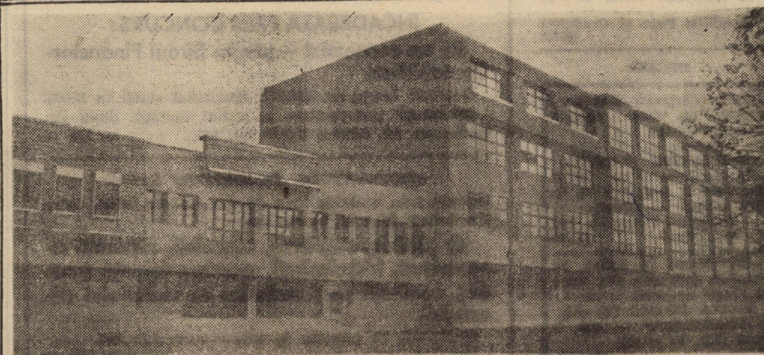
Fațada unor noi construcții din Piața Cibin din localitate, aparținînd întreprinderii „13 Decembrie” Sibiu Foto: Fred NUSS
