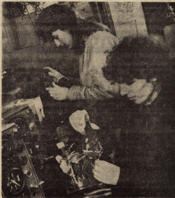
Calitatea lucrărilor executate de către tinerii atelierului electric din cadrul secției construcții-montaj de la I.U.P.S. Sibiu reflectă devotamentul față de muncă, buna lor pregătire profesională. Foto: Fred NUSS
