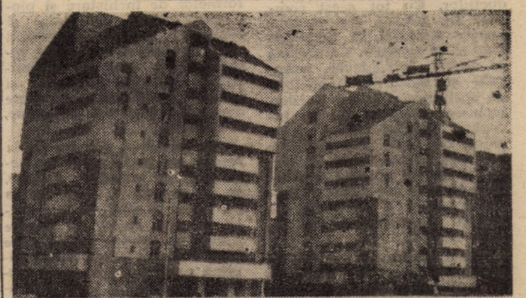
Dintre noile construcții de locuințe ridicate recent pe str. N. Teclu din Sibiu. Foto: Fred NUSS
