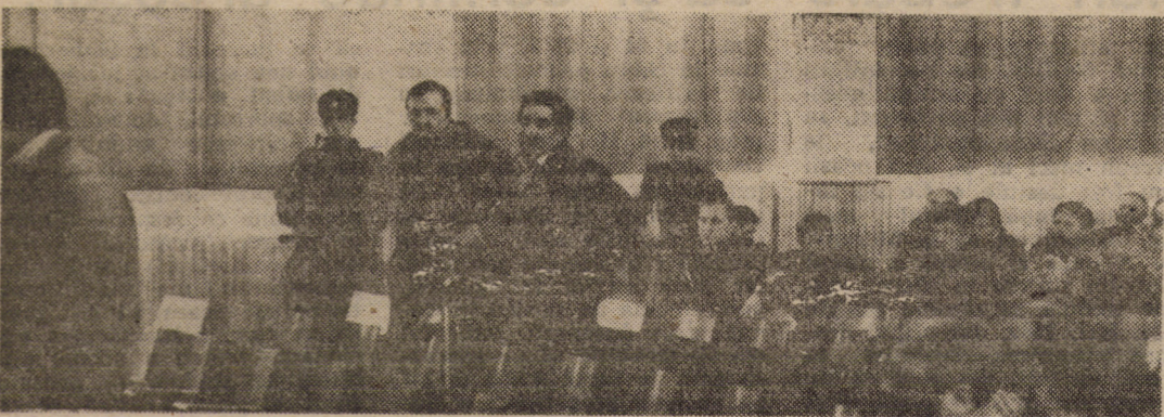
În fața probelor zdrobitoare se așteaptă sentințele pe măsură
