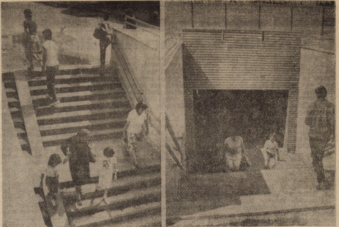
Recent, în apropierea gării din Sibiu, la capătul str. Lupeni, a fost dat în folosință un pasaj subteran, înlesnind trecerea în siguranță a pietonilor pe sub calea ferată. Astfel vor fi evitate pe viitor numeroasele accidente, petrecute în acest loc Foto: Andrei BUTA
