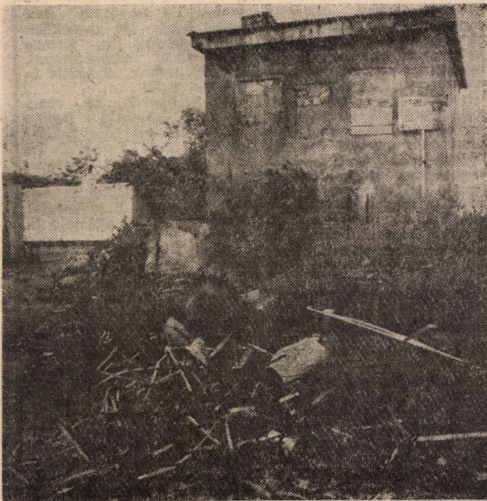
Pe strada Dr. Bagdasar, lângă Spitalul nr. 3, există un morman de tablă și gunoaie. Întrebînd un cetățean care locuia în zonă, de cînd se află acolo gunoii, mi-a răspuns: „Din totdeauna”. Foto: Andrei BUTA
