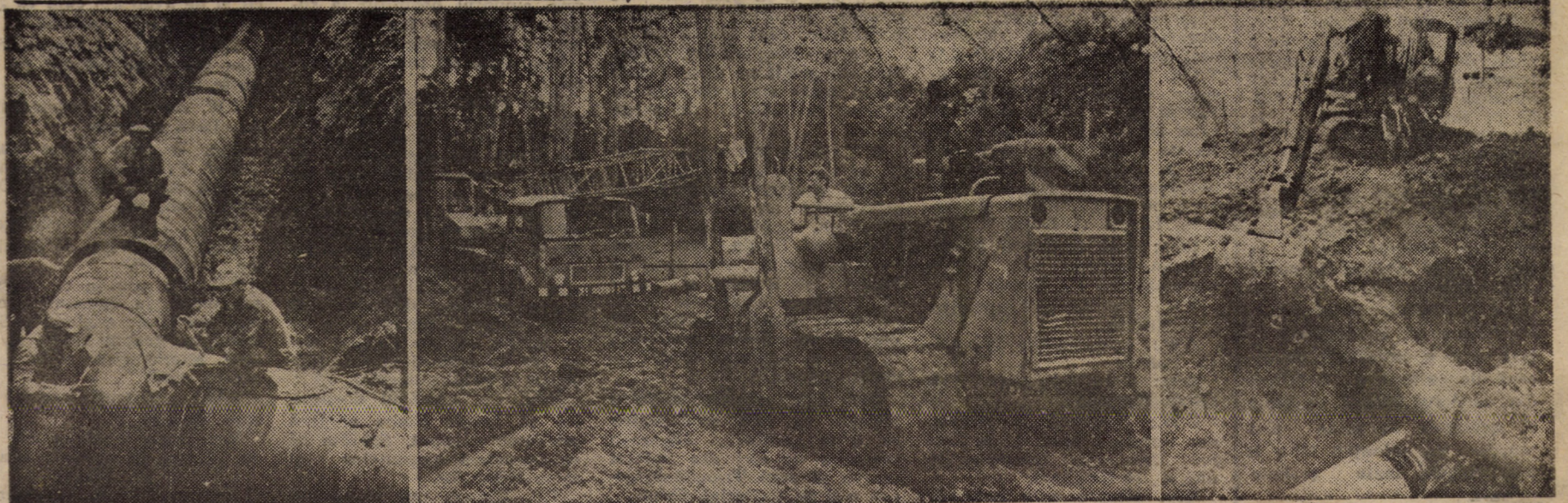
Cîteva din punctele dificile pe traseul conductei de aducțiune, rezolvate cu profesionalism de constructorii sibiieni
