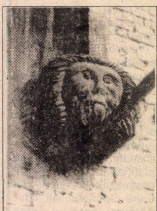
Detalii de arhitectură la casa Altemberger
