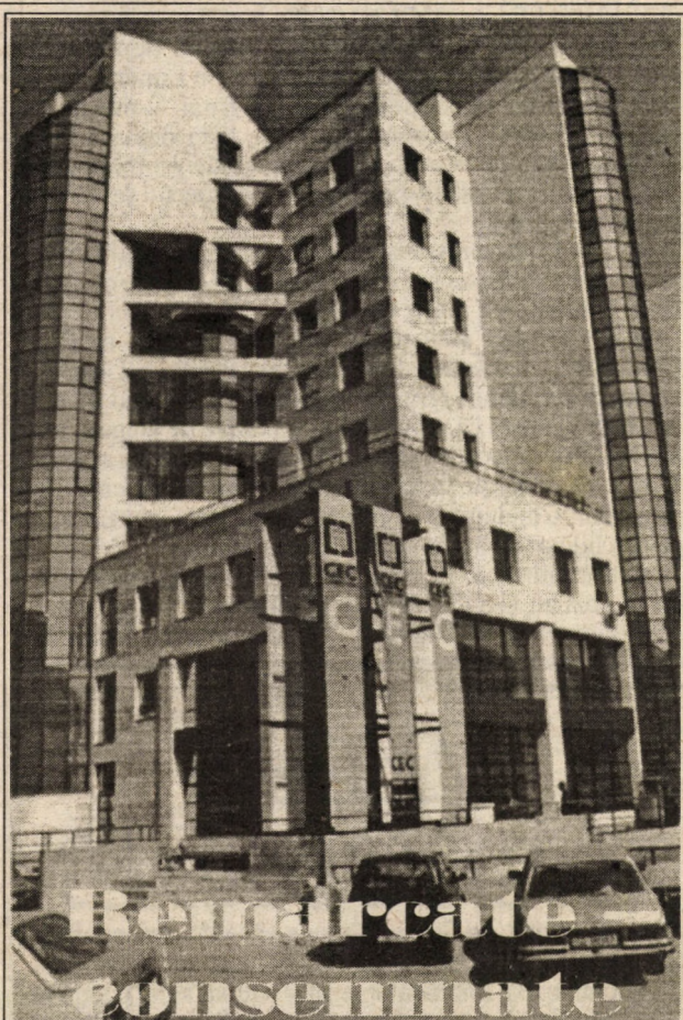
De curând, în spatele clădirii CEC-ului sibian de pe Calea Dumbrăvii, au fost finalizate ultimele lucrări de finisare la impunătoarea construcție (vezi imaginea). Oricum, care dintre sibieni nu se fâlește cu asemenea "gigant"? Text și foto: Fred NUSS
