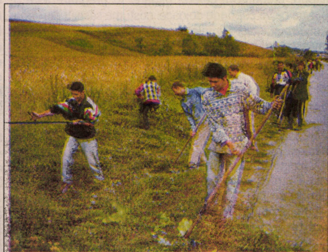
Beneficiarii prevederilor Legii 1416/2001 - un sprijin real al Primăriei în executarea unor lucrări edilitar-gospodărești
