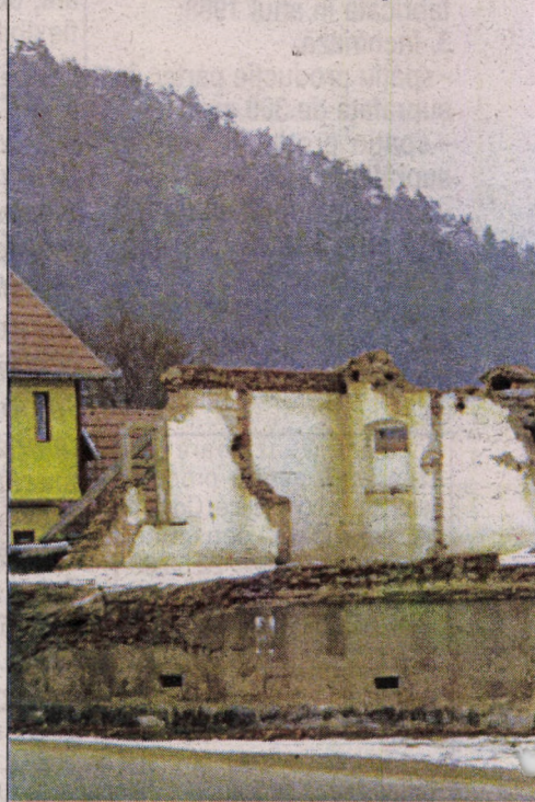
Ruinele bibliotecii de la Șeica
