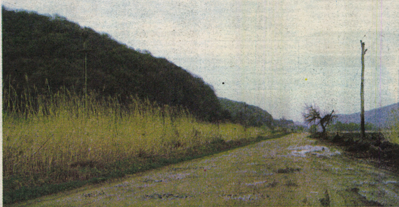
O porțiune de drum are tratament bituminos
