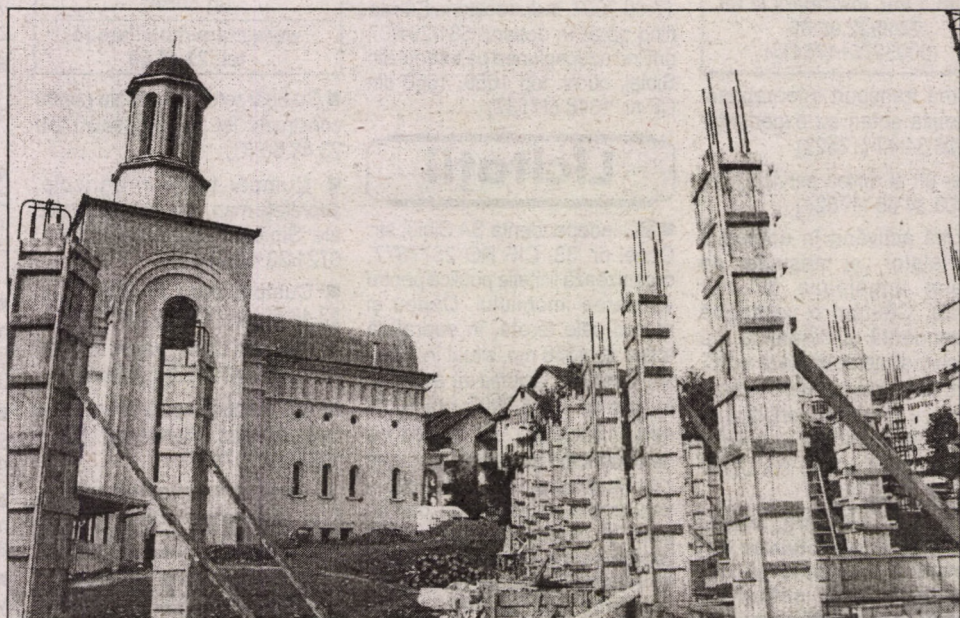
Șantierul unde se construiește noua casă a Centrului social pentru copii și vârstnici în dificultate, în Valea Aurie, Sibiu
