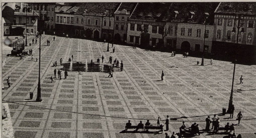
refolosite pietrele de râu care păstrează specificitatea centrului istoric al Sibiului. Pentru a delimita zonele de plantare a arborilor s-au folosit borduri de andezit, iar
